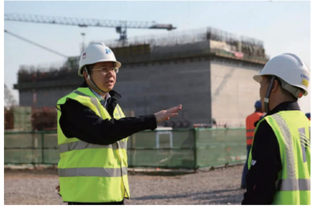
贺云生在高温气冷堆建设现场
