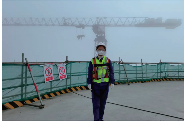
张迪在核电项目现场跟进试验
